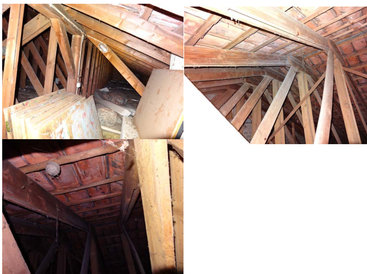
Abbildung 4 a bis c: Dachstuhl 2
