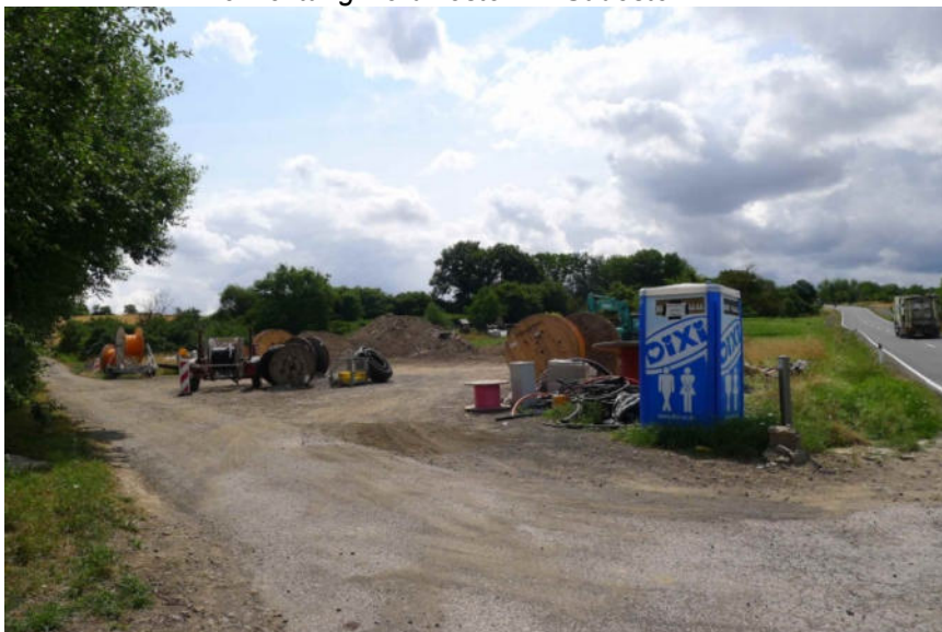
Abbildung 2: Blick auf das für den Neubau vorgesehene Gelände in Blickrichtung Nordwesten → Südosten
