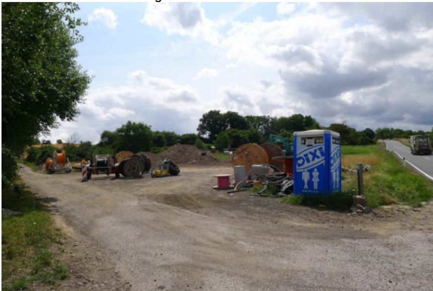
Abbildung 11: Blick auf das für den Neubau vorgesehene Gelände in Blickrichtung Nordwesten → Südosten
