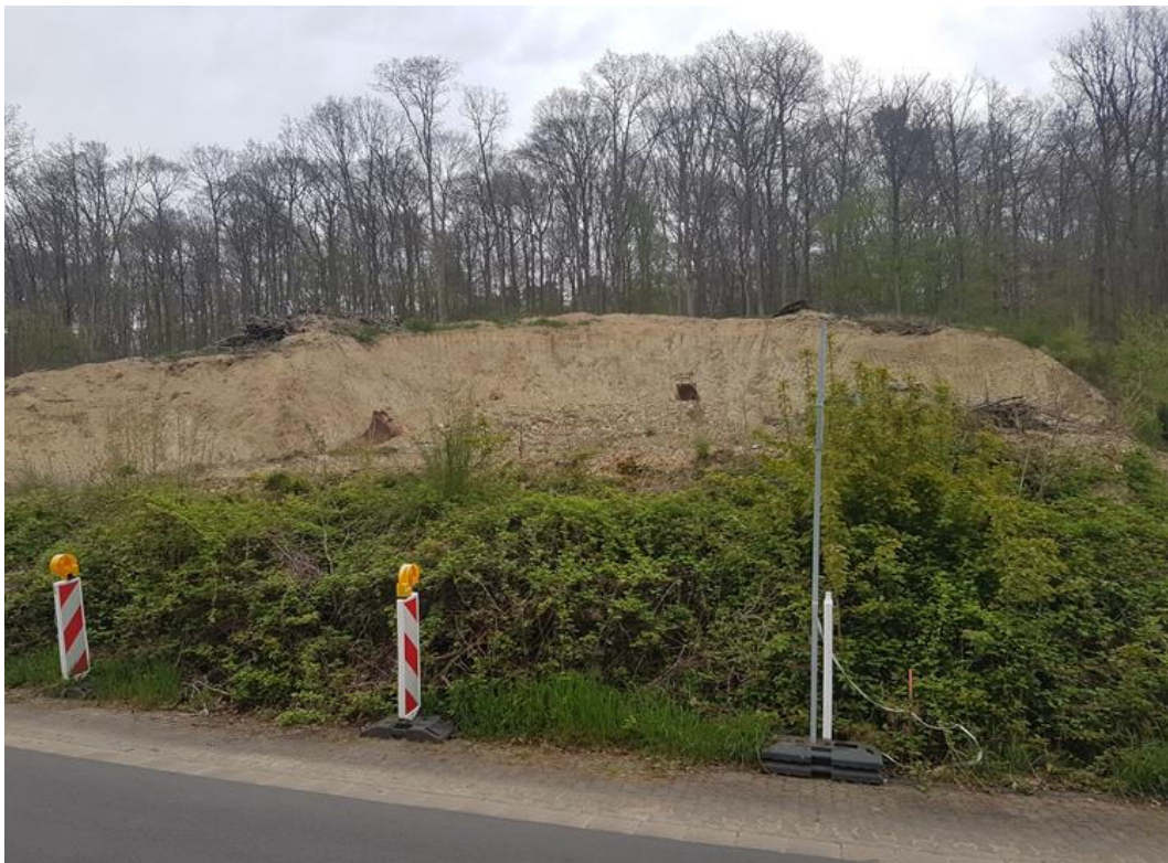
Baugruben an der Sebastian-Kneipp-Straße (Blickrichtung Osten)
